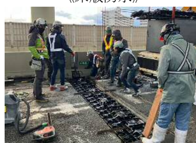
《伸縮継手取替》
