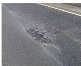
《舗装の損傷》
